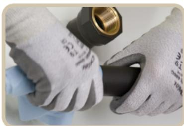
**Nettoyer les parties à encoller** Femelle puis Mâle avec le primaire d'accroche Cleaner+. Utiliser un chiffon propre. Laisser sécher ou sécher à l'aide d'un chiffon doux. En cas de non-application du Cleaner+, les performances de soudure sont réduites et peuvent provoquer des faiblesses dans l'assemblage.
